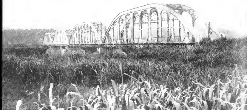
Grand pont métallique de Bukama.
